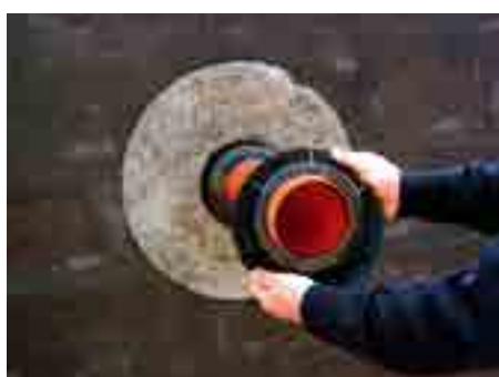
4. Установить фиксирующую гайку
