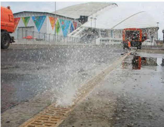
■ Канал в процессе прочистки гидродинамическим способом
