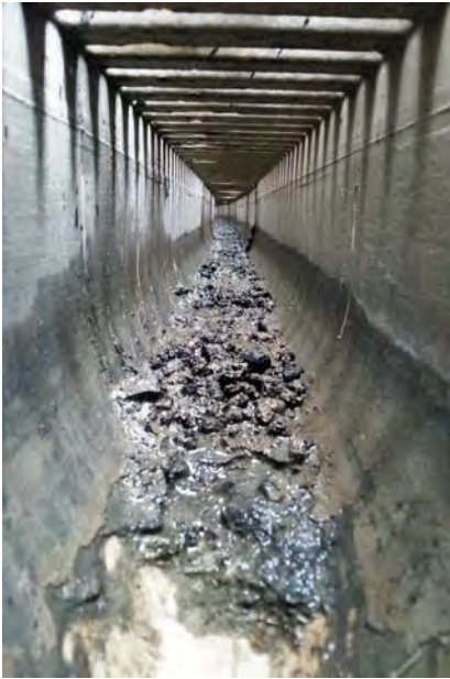
■ Канал до очистки
