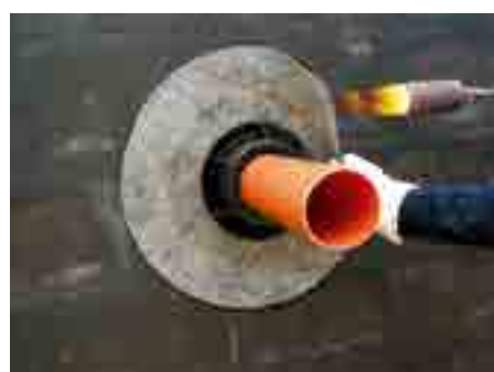
5. Приварить мембрану к битумному покрытию стены
