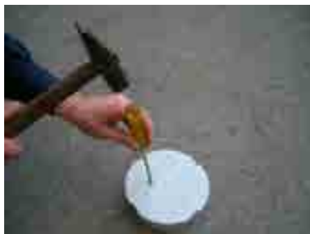
2. В монтажном элементе подготовить отверстия нужного диаметра
