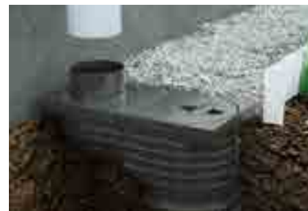
3. Присоедините водосточную трубу
