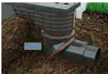
4. Отрегулируйте направление и угол установки выпускного патрубка
