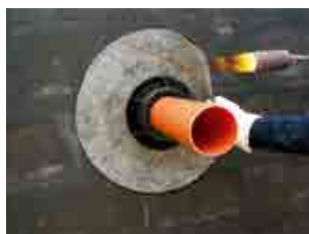
5. Приварить мембрану к битумному покрытию стены
