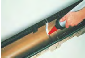
Нанесение герметизирующей массы
